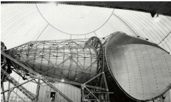
Radôme de Pleumeur-Bodou ( 64m de diamètre pour protéger l'antenne de 340 tonnes ) afin capter le satellite Telstar
